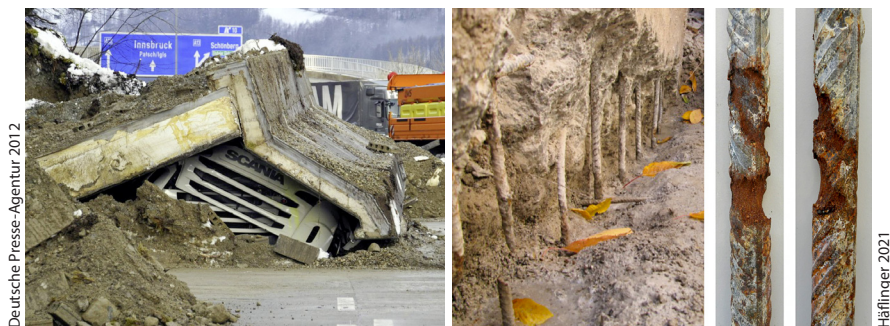
Abb. 1: Versagen einer Spornmauer auf der Brennerautobahn (links) und Korrosionsschäden im Bereich der Arbeitsfuge bei einer Winkelstützmauer (rechts)
