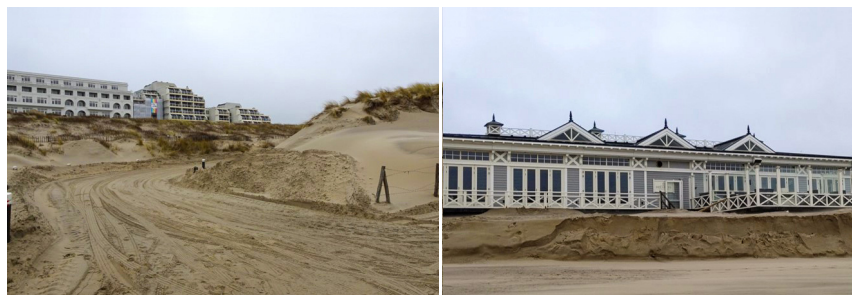
Abb. 1: Links: Mit Sand bedeckte Strandzufahrt. Rechts: Sandwall angelegt zum Schutz der Terrasse und des Cafégebäudes vor einem Sturm, der anschließend teilweise durch die Witterungsbedingungen erodiert ist.
