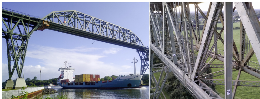
Abb. 2: Schwebeträger der Eisenbahnhochbrücke Hochdonn (links) und Detailansicht des Stahlfachwerks in einem Kragträger (rechts)
