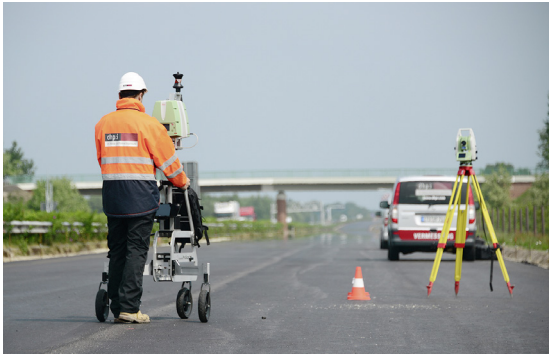
Abb. 6: Asphaltdeckenmessung im Straßenbau
