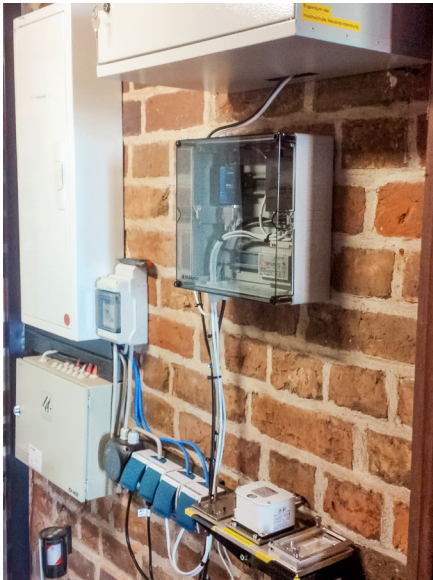
Abb. 2: Unix-Server mit Monitoring-System, Sensorsteuerungseinheit und Leica Nivel210 auf einer Konsole im Kirchturm
