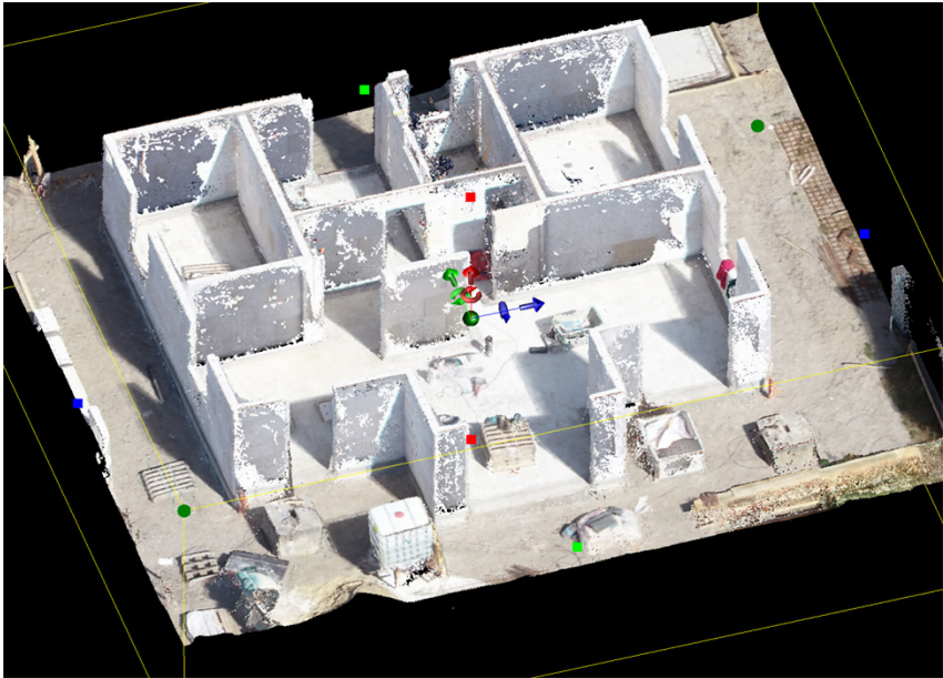
Abb. 5: Punktwolke eines Rohbaus zur Dokumentation von Bodenplatte und Erdgeschoss-Außenwänden im Rahmen einer Sockelabnahme
