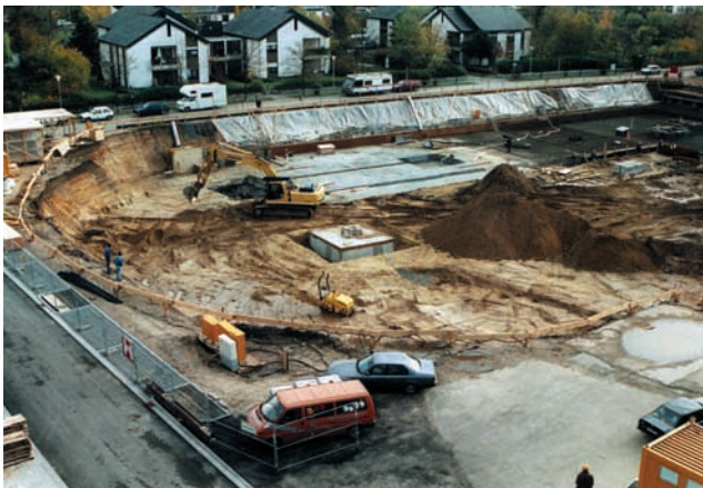
Abb. 9: Baugrube mit Schnurgerüst
