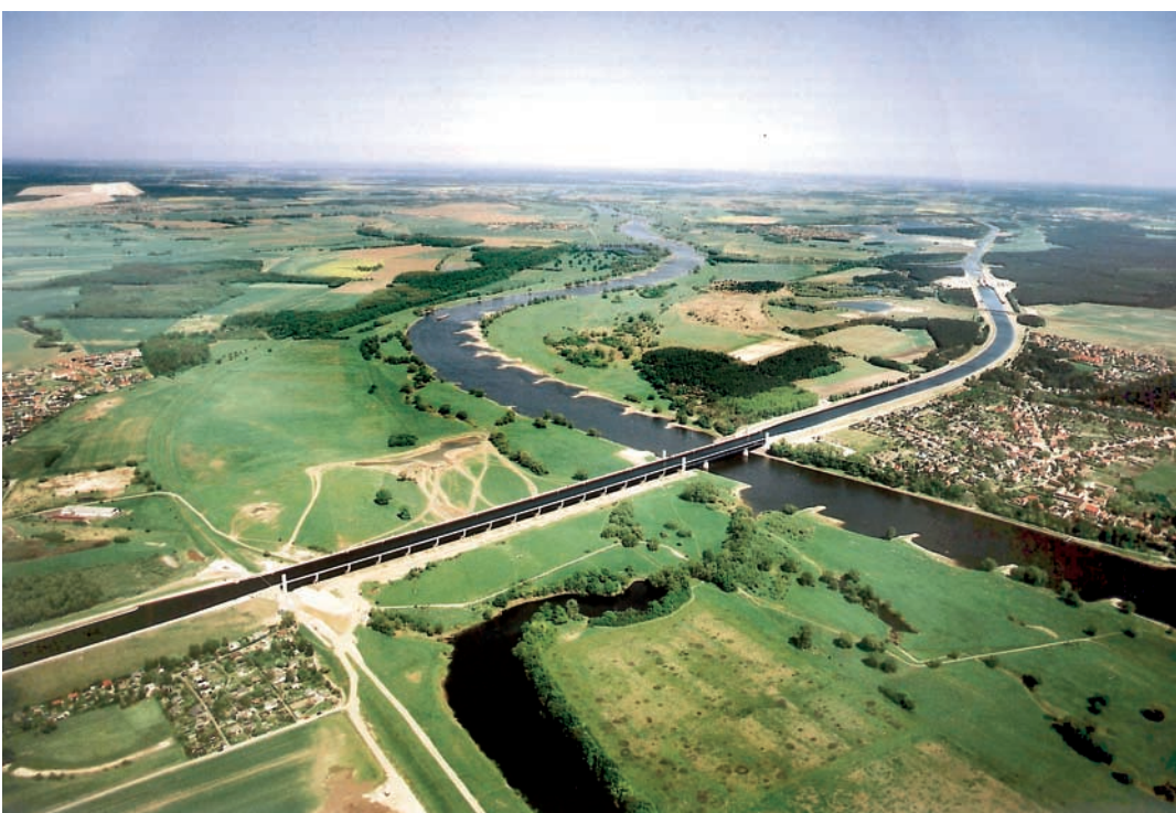
Abb. 1: Die Kanalbrücke aus der Vogelperspektive
