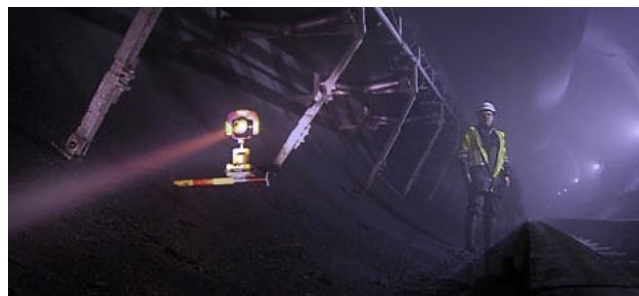
Abb. 8: Konventionelle Vermessungsarbeiten im Headrace-Tunnel und Konsolenfestpunkte
