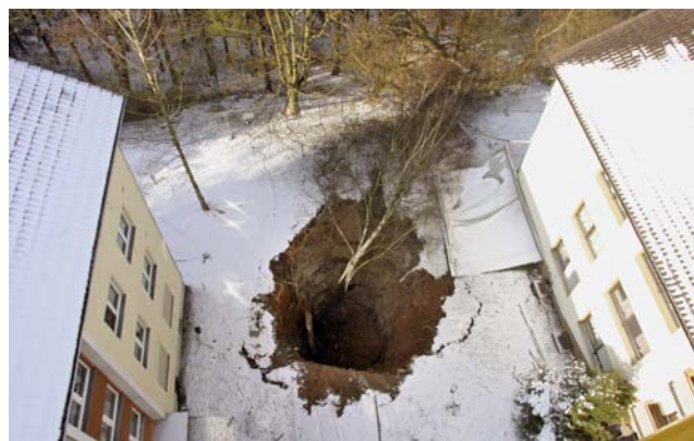
Abb. 1: Tagesbruch in Siegen-Rosterberg (Februar 2004)
