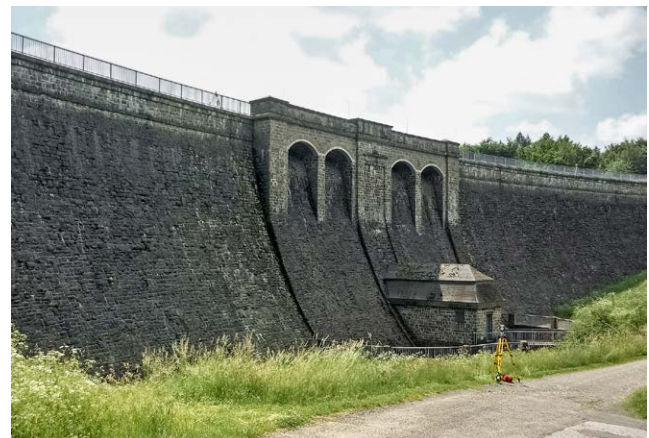
Abb. 18: Brucher-Talsperre aus Sicht der Luftseite
