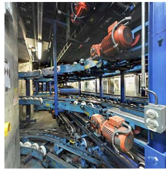
Abb. 15 und Abb. 16: Gepäckförderanlage
