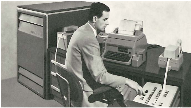
↑ Abb. 13: Programmgesteuerte Rechenanlage Zuse Z 25 aus dem Jahr 1963. Die Zuse KG in Bad Hersfeld war zu dieser Zeit weltweit einer der führenden Hersteller von Computern und warb explizit mit der Anwendung ihrer Produkte (neben Rechnern u.a. auch ein elektronisches Planimeter und eine Lochstreifengesteuerte Zeichenanlage) im Vermessungswesen.
