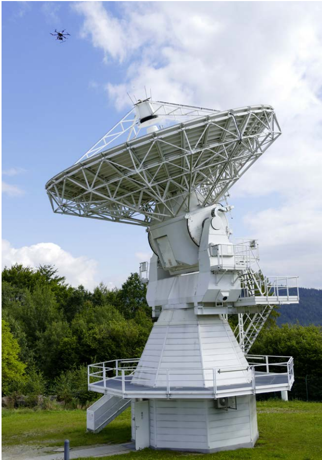
Abb. 3: Südliches VGOS-Radioteleskop TTW-2 während der photogrammetrischen Erfassung von Daten zur Ermittlung von lastfallabhängigen Deformationen an der Empfangseinheit am Geodätischen Observatorium Wettzell.
